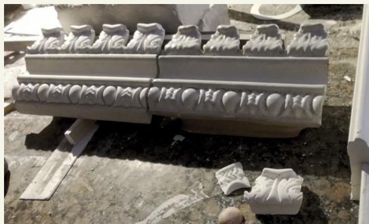
Vergleich von Originalteil und neu gefertigtem Modell
